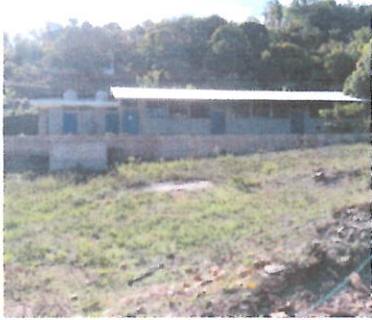
Foto1: Pintura en Muros interior y exterior
