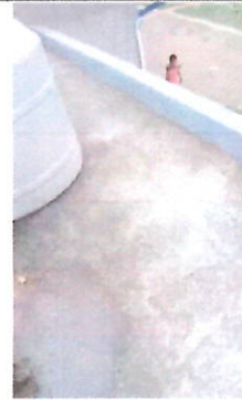
Foto 4: Impermeabilizacion de losa, aplicación de sistema de impermeabilizacion, limpieza profunda de la superficie y aplicación de impermeabilizacion
